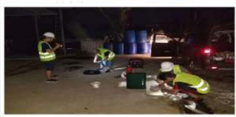
Аварийная обработка химических утечек на химическом заводе
