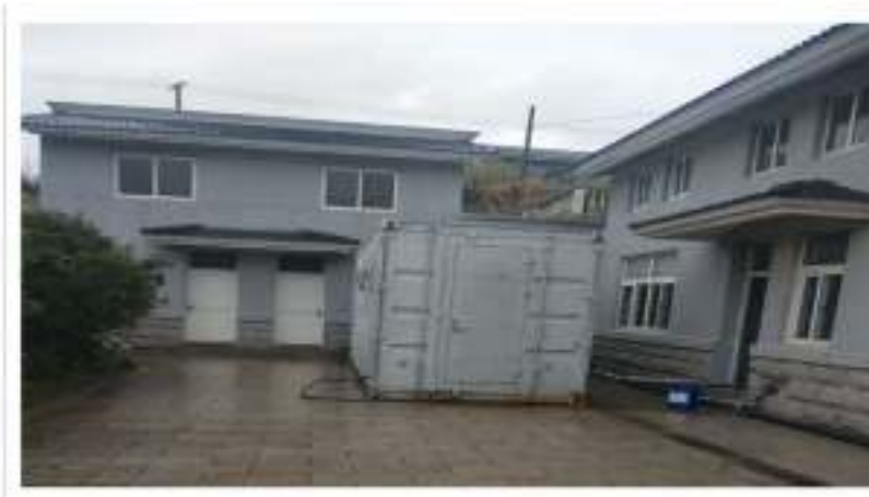
Островная система аварийного водоснабжения
